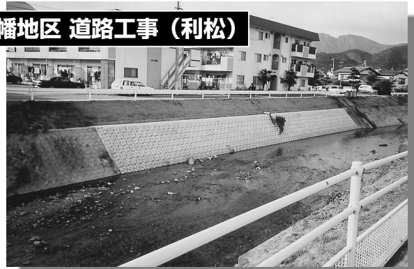
昨年の6.29災害で河川側の道路法面が浸食被害を受けましたが改修されました。
