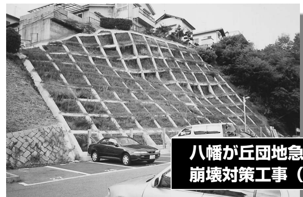
危険にさらされていた法面保護工事が完了しました。
