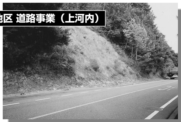
(県) 五日市筒賀線の法面崩壊の復旧が完了しました。
