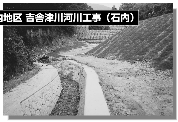
昨年の6.29災害で大きな被害をもたらしましたが谷止工の完成と河川の復旧が完了しました。
