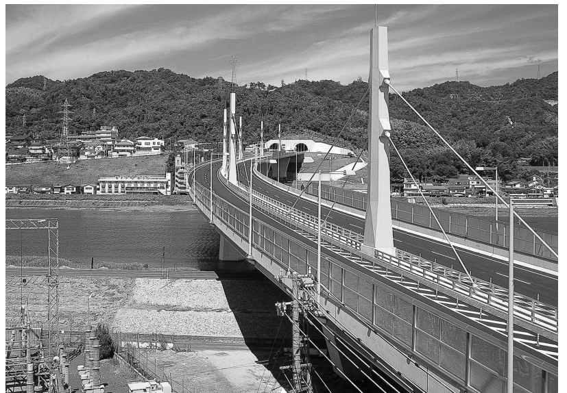
西区中広町側から見た広島西大橋
