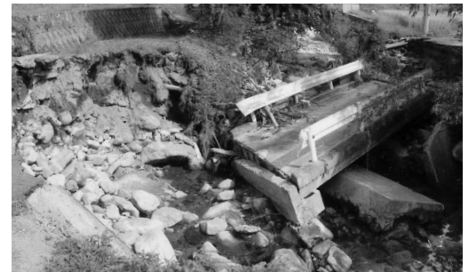
河川護岸(伏谷川)の崩壊による落橋現場 (湯来町大字伏谷 堀田銘木店付近)
